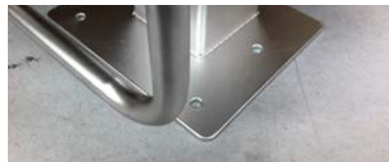
Exemple de platine spéciale réalisée pour fixation sur ancrage existant.
